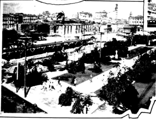
El Paseo de Martí, frente al Capitolio en construcción, cuyos andamiajes fueron arrancados por el huracán.
