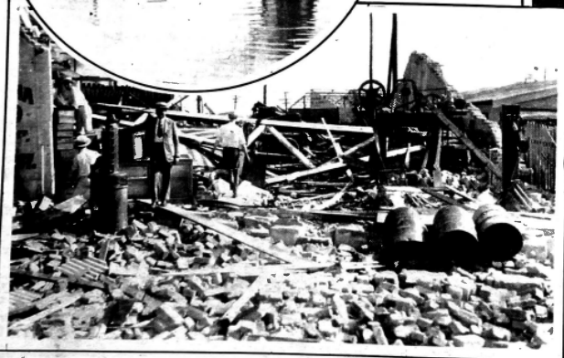
Lo que queda de un garage que se alzaba en la calzada de Luyanó.
