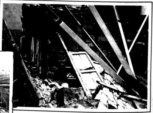
Ruinas de la casa de la Calle de Fernandina, en cuyo derrumbe perdieron la vida cuatro personas.
