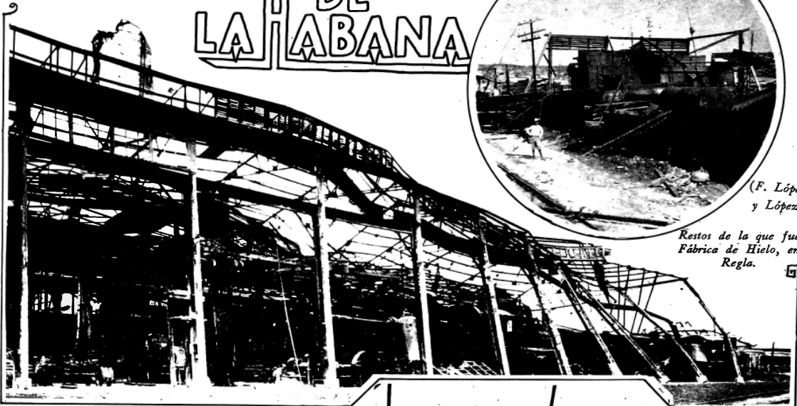
El Central Toledo después del ciclón: el esqueleto de un gigante caído.
